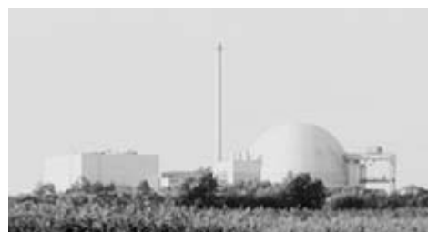
Unterweser (Esenshamm) Nuclear Power Plant
