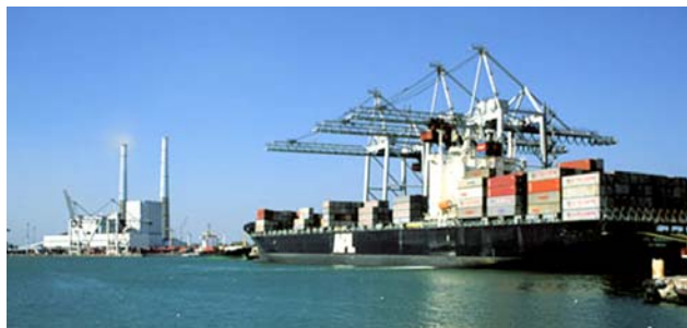
Le Havre (container terminal)
