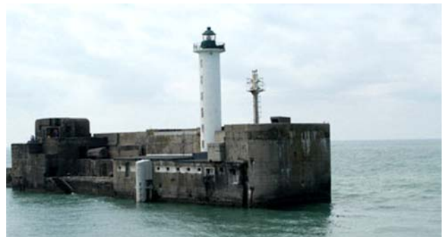
Digue Carnot Light
