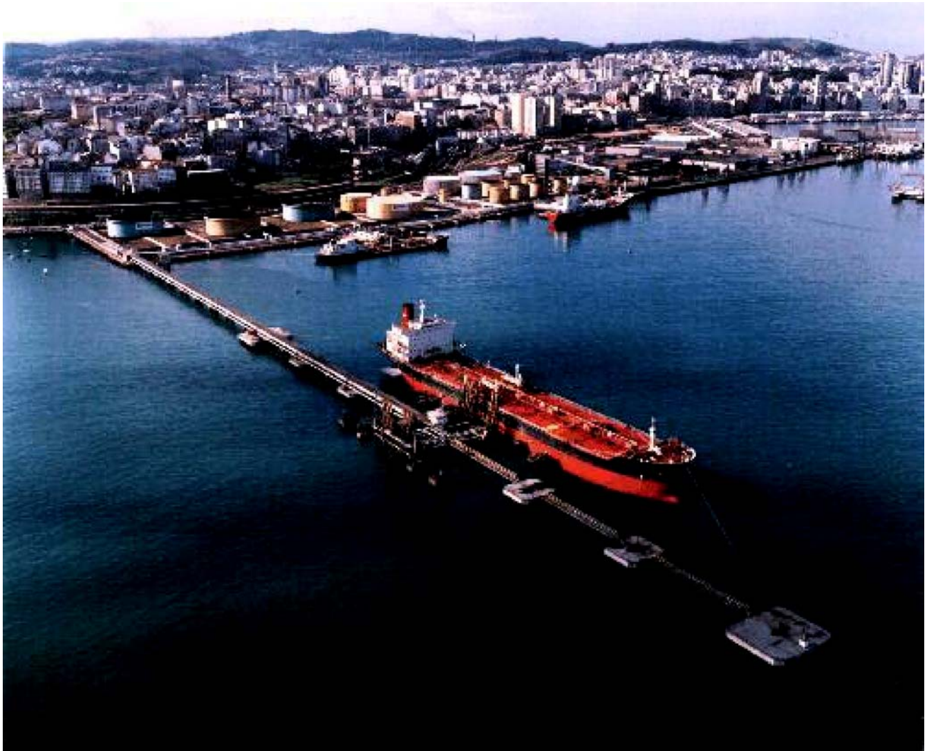
Puerto de La Coruña—Tanker Pier
